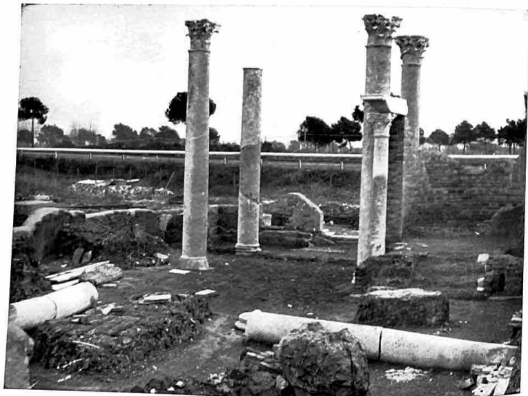
Fig. 6 - Ostia, Sinagoga: veduta da nord-ovest dopo il restauro.
