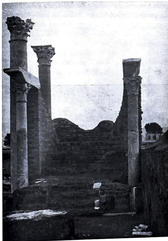
Fig. 2 — Ostia. Sinagoga. L'edicola della Torah dopo il restauro.
