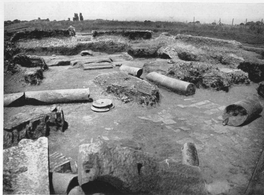
OSTIA - Parte interna dell'aula sinagogale con la parete abbattuta
