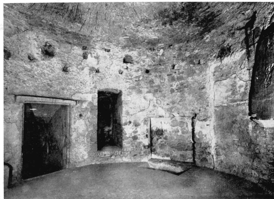
1. - Ostia antica - Sala del torrione di Martino V incorporato nel mastio del castello
