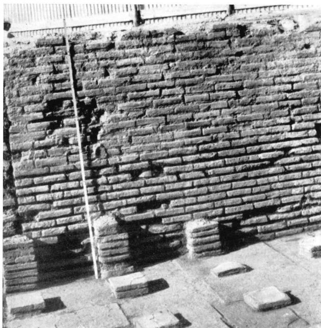
36 - Fondi, Edificio termale: Uno dei vani con le suspensurae della seconda fase.
